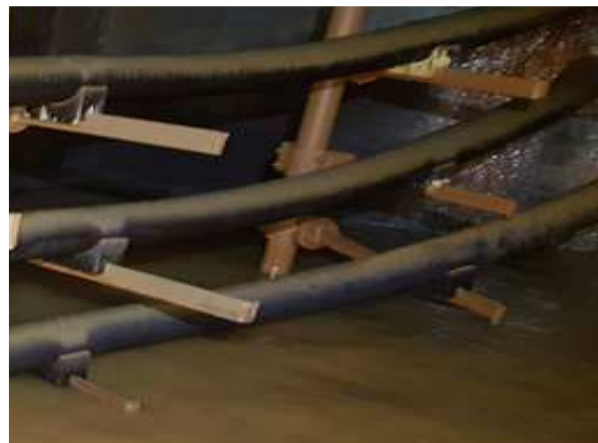
내용 지지대 상태양호 상태양호
